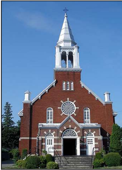
Construit en / Built in 1896 Rénové en / Renovated in 1920
